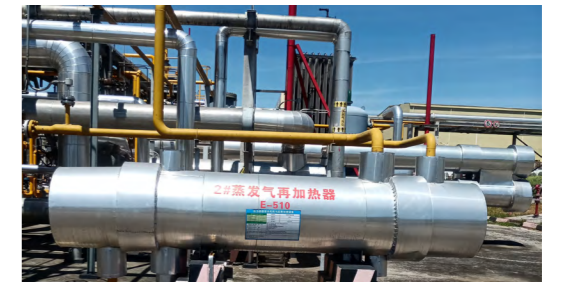
蒸发气再加热器
