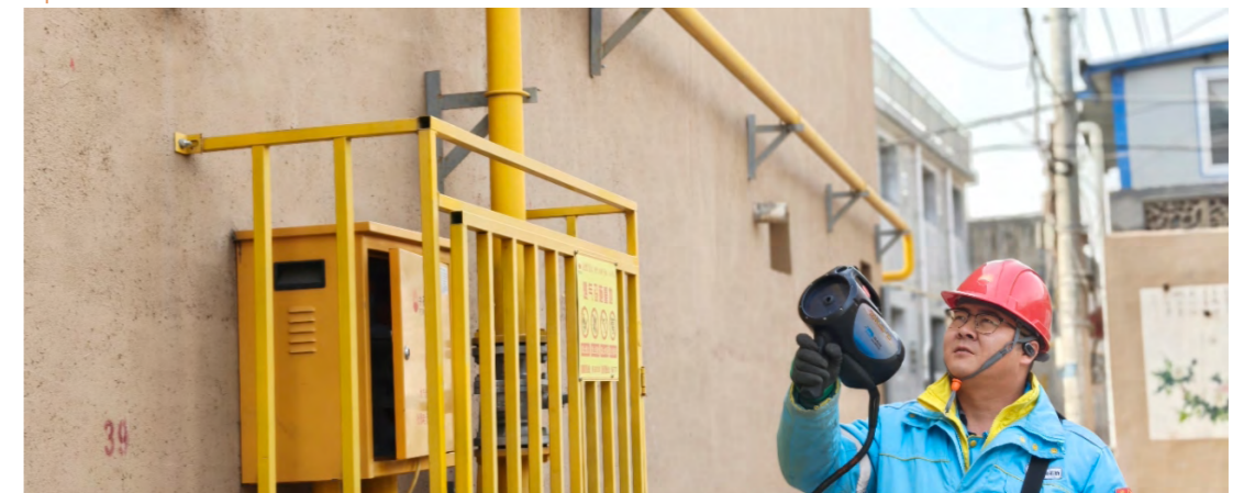
乡村管网设施安检巡查
