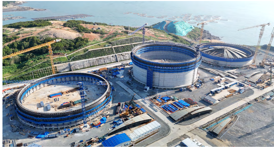
福建 LNG 施工现场实景图
