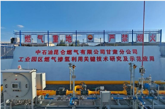
玉门工业园区天然气掺氢示范项目
