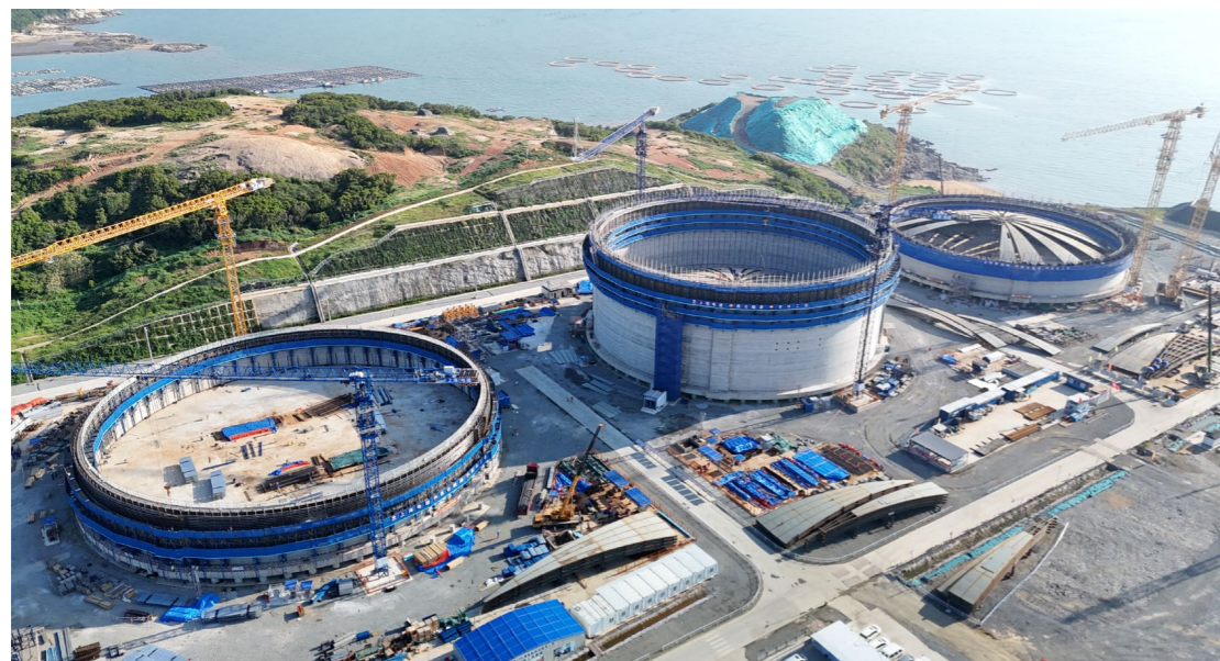
Real-life Photo of Fujian LNG Construction Site
