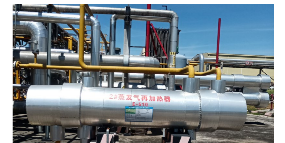
蒸發氣再加熱器
