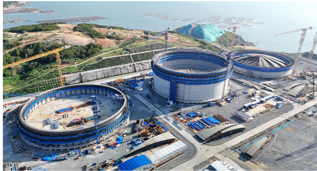
福建 LNG 施工現場實景圖
