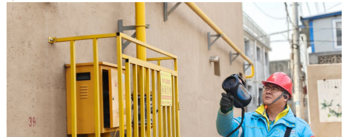
鄉村管網設施安檢巡查
